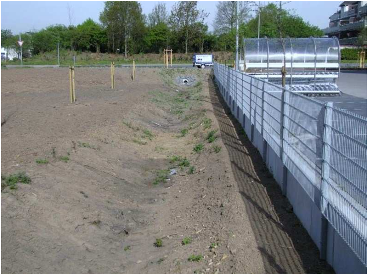
Blick zur Düsseldorfer Landstraße nach den Bauarbeiten des Parkplatzes und des Kreisels
